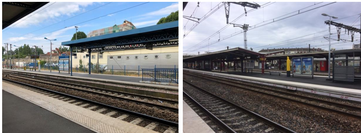
Exemples de dispositifs doubles sur quais de gare (hors territoire)
