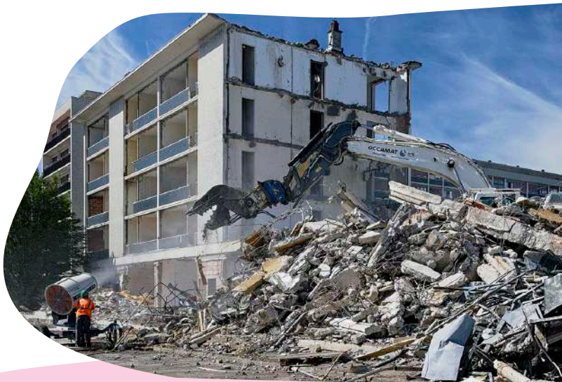
Démolition de la barre Saint-Paul dans le quartier du Sanitas à Tours
