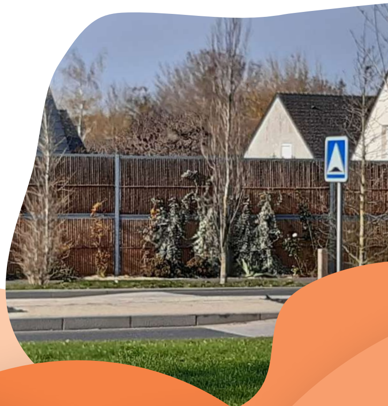
Mur anti-bruit en fibre de coco sur la route de Monts à Joué-lès-Tours
