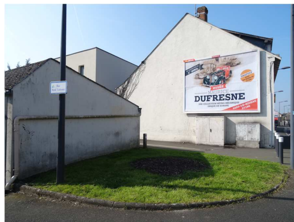
Dispositif mural dépassant la limite de l'égout du toit
