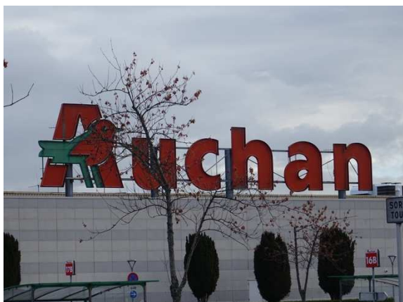
Enseigne en toiture
